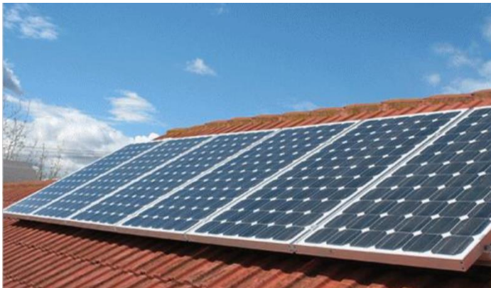
Hệ thống năng lượng mặt trời tiết kiệm năng lượng (khu vực chung)
